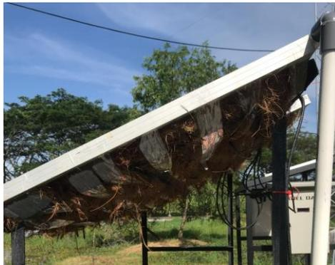
Gambar 6. Sistem Pendingin menggunakan Sabut kelapa
